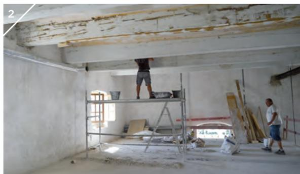
Dans l'aile Est au niveau 0, un mur dont on aperçoit la trace et qui soutenait en partie le plafond voûté de la pièce a été détruit pour agrandir la pièce Photo 3.
