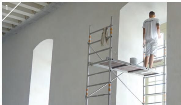
Dans la mezzanine de l'aile est, les poutres d'origine, sont reprises au plâtre afin que les moindres recoins du chantier soient parfaits Photo 2.
