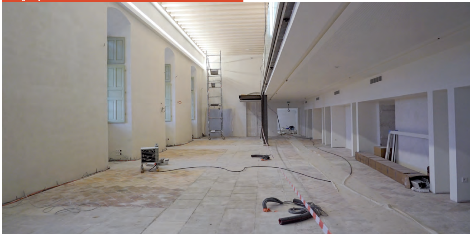
Dallage de pierres marbrières au rez-de-chaussée
