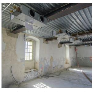
Dans les deux ailes, les entreprises commencent maintenant à mettre en place, sur des rails suspendus aux plafonds, les conduits et les répartiteurs de chauffage (4)
