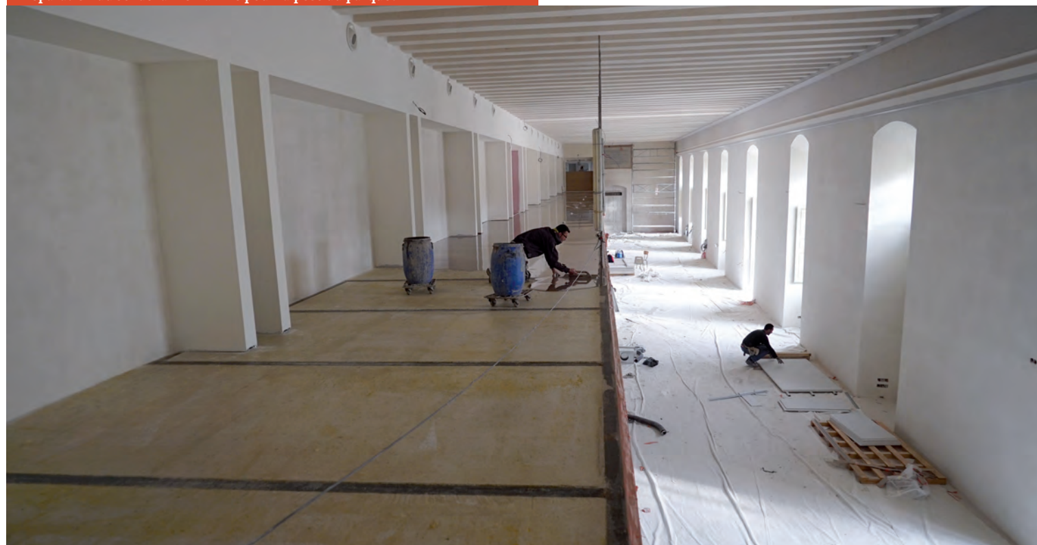
Préparation du sol de la mezzanine pour la pose du parquet
