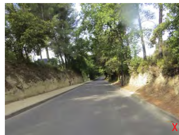
X Elargissement du chemin rural avec aménagements de trottoirs avec bordure et terrassement du front de taille de l'ancien chemin(3)
