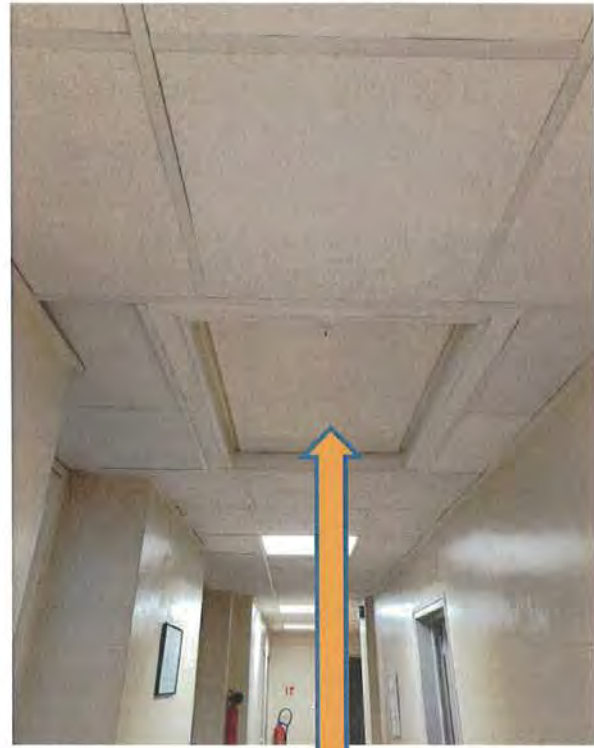
Trappes d'accès (2 ème étage) pour accéder aux combles.
