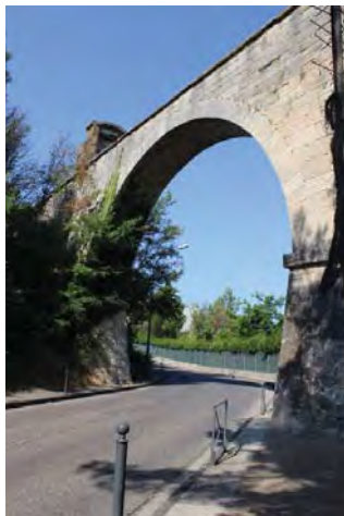
PASSAGE DE ROUTE SOUS L'AQUEDUC
